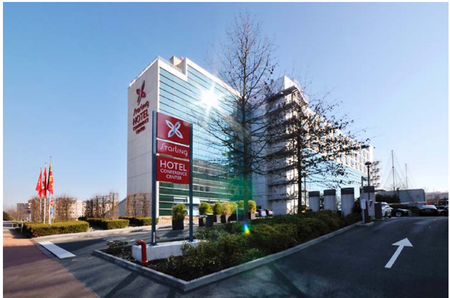
Energiespar-Contracting: Das Konferenzhotel Starling in Genf ist eines der Beispiele. 2012 konnten zahlreiche Effizienzmassnahmen in den Bereichen Heizung, Kühlung und Beleuchtung umgesetzt werden. (Bild: swissesco)
